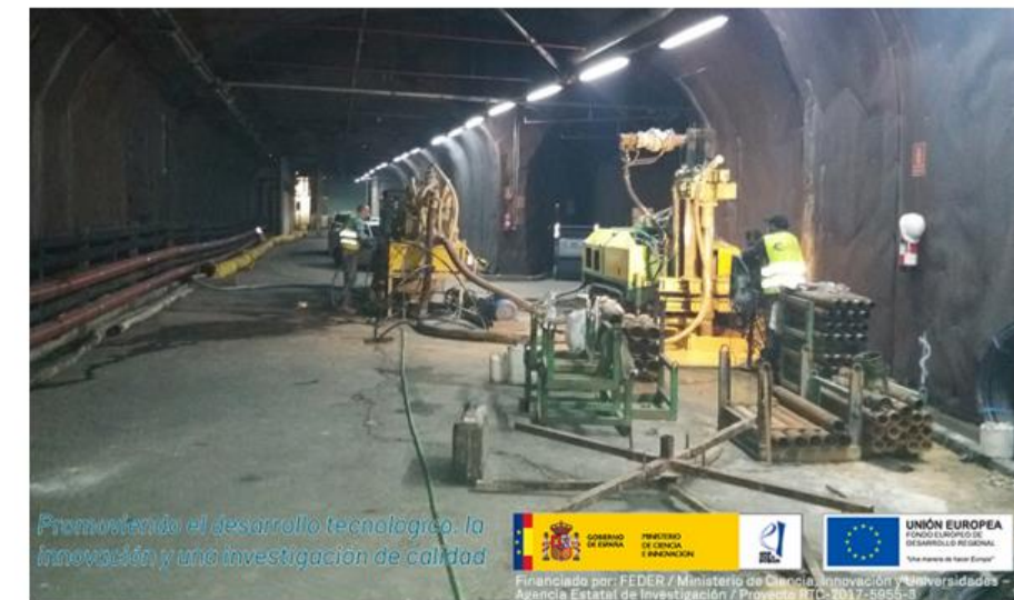
Perforación de los sondes geotérmicos en uno de los túneles del Intercambiador de Moncloa.
